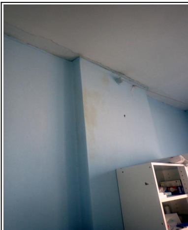
Foto 10: 111: opstijgend vocht / doorslaand vocht slaapkamer, licht verhoogde vochtwaarde
