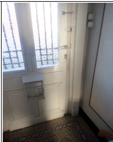
Foto 11: 121: ernstige tekortkomingen (houtrot/corrosie/disfunctie) voordeur klemt
