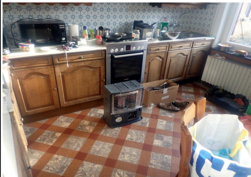
Foto 17: 227: indicatie van een risico op CO-vergiftiging keuken, mobiel verbrandingstoestel
