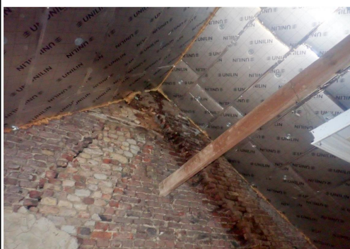
Foto 39: zolder, isolatie hoofdegebouw
